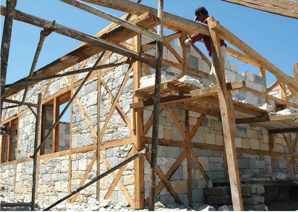
Ahşap karkaslı taş depo binasında restarasyon çalışmaları.
