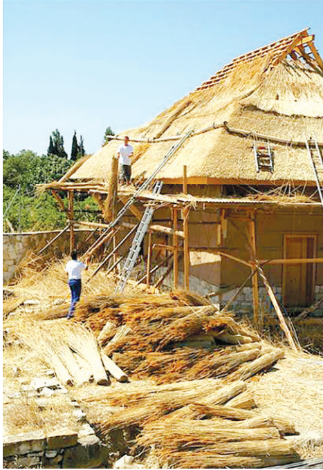
Baba oğul Barfuss ustalar çatıyı kamış ile örüyorlar.
