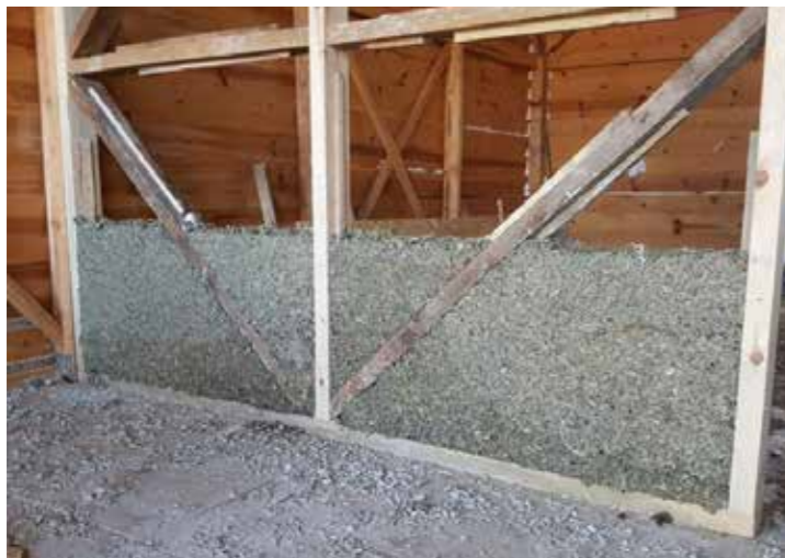
Fotoğraf 4. Yerinde döküm tekniğiyle üretilen kenevir-beton duvar dolgusu. [Fotoğraf: Ash Tekin]
